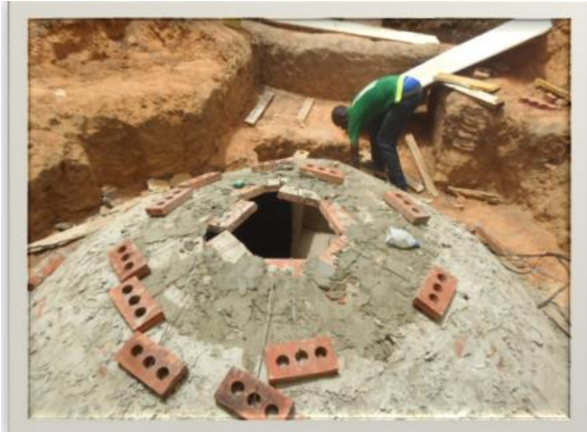
Figure 2.3 : Construction du dôme du Bio A
