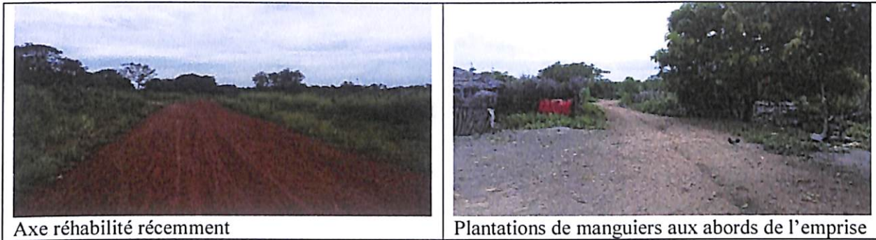
Photo 4 : Illustrations sur le profil de l'emprise du tronçon Bancouroto-Saré Yoro Sow
