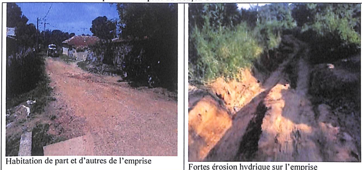
Photo 2 : Illustrations sur le profil de l'emprise du tronçon Guindir-Samine-Diambacounda
