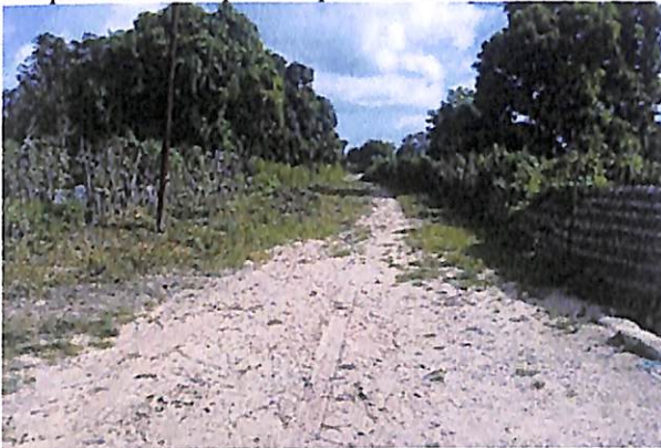
Poteaux électriques sur l'emprise de la route
