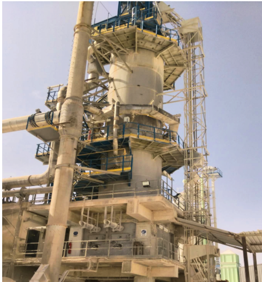
FIGURE 1.2 – Four vertical ou four droit à chaux chemisé intérieurement avec un matériau réfractaire [5]
