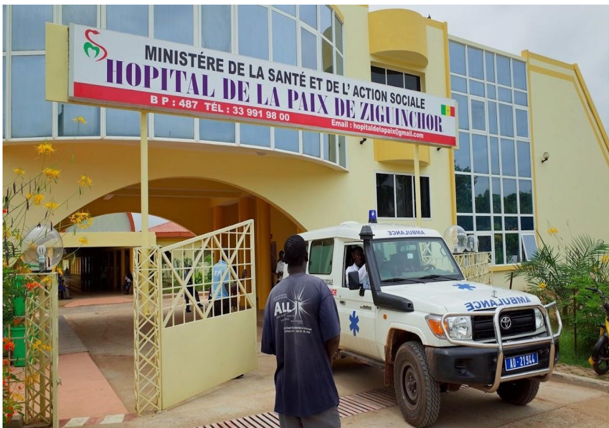
Figure 26 : Hôpital de la paix de Ziguinchor.
