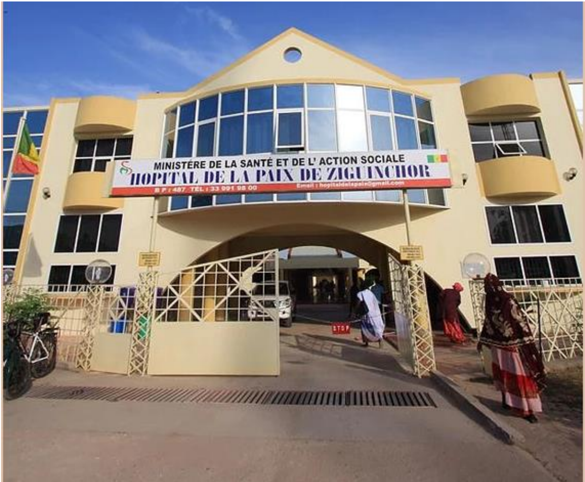
Figure 9 : Hôpital de la paix de Ziguinchor vue de face [78]
