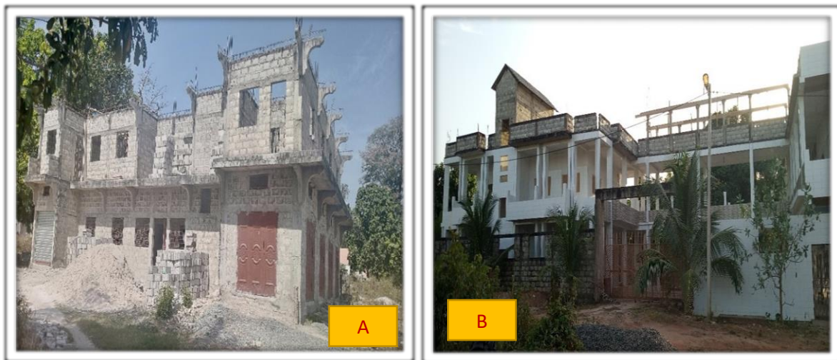
Photo 1 : Maison en chantier à Kénia (A), construction moderne à Boutoute(B) : (Décembre, 2022)
