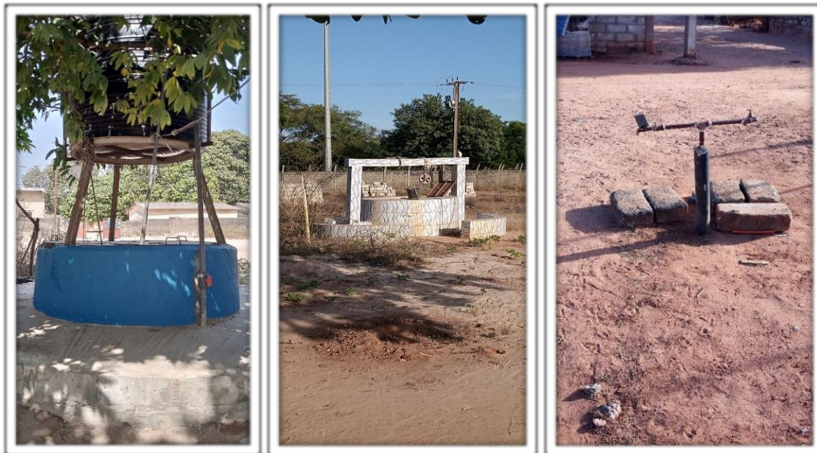
Photo 4 : un mini forage à Kénia
