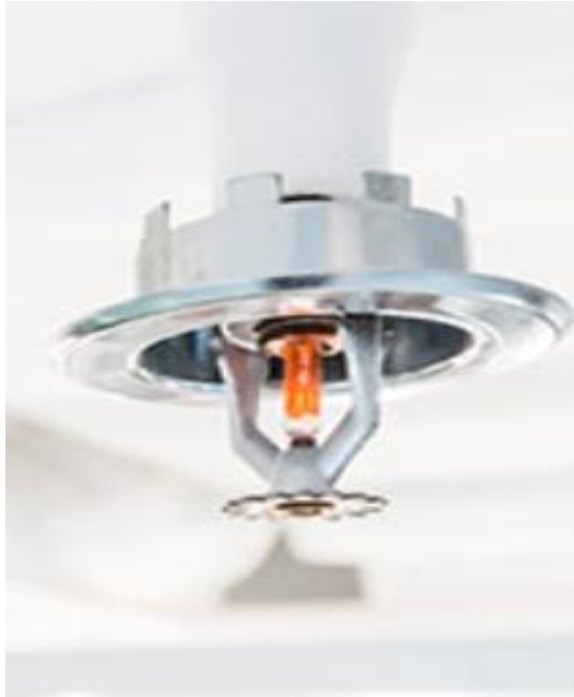
Figure 5 : le système sprinklers
