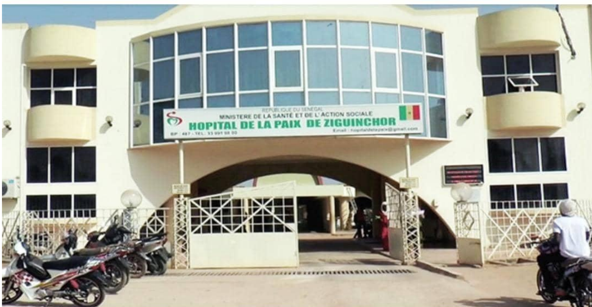
Figure 6 : Hôpital de la Paix de Ziguinchor (vue de face)
