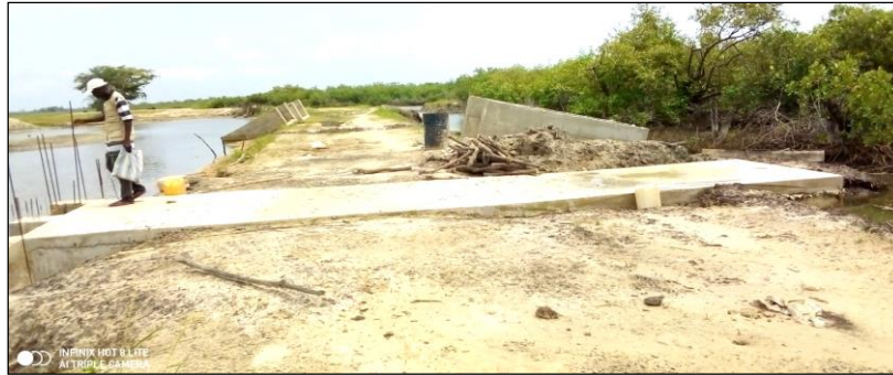
Photo 3: Ouvrage hydro-agricole en cours de réalisation à Cabrousse dans la commune de Diembéring depuis Août 2021 (Source : Djiba, 2021)
