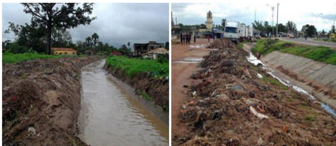
Planche photos 7: Curage des caniveaux d'évacuation des eaux pluviales à Ziguinchor (Ba, 2013)
