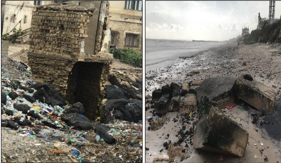
Photographie 13 : Destruction des habitations sur la plage de Diokoul Wague (Faye, septembre 2022)
