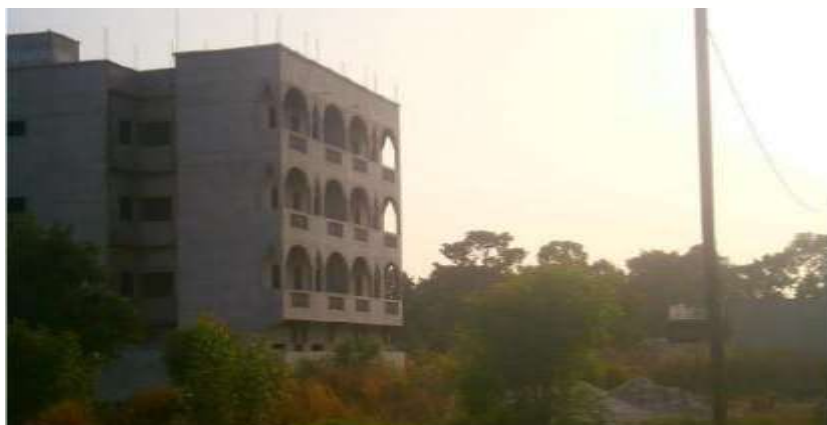
Photo 2 : immeuble en cours de finition dans un champ débarrassé de ses cultures en septembre 2014. (Sy, 2015)
