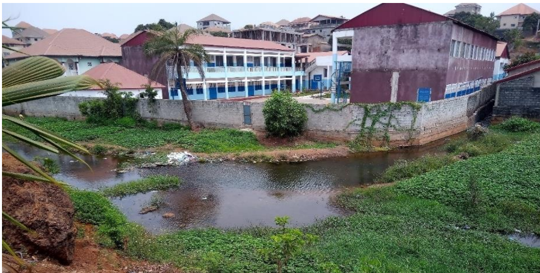
Photographie 22 : Construction sur le lit du cours d'eau de Sonfonia centre (Bah, 2022)
