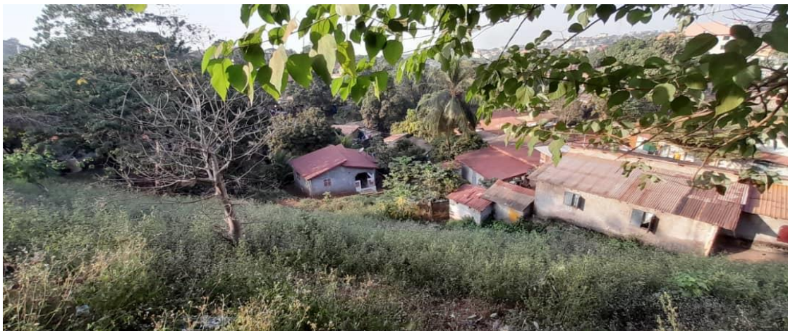
Photographie 20 : Construction dans la forêt de Kakimbo (Bah, 2022)
