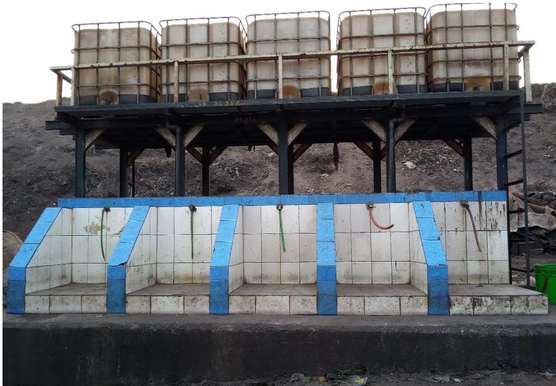
Photographie 18 : Forage public dans le quartier de Dar-Salam (Bah, 2022)
