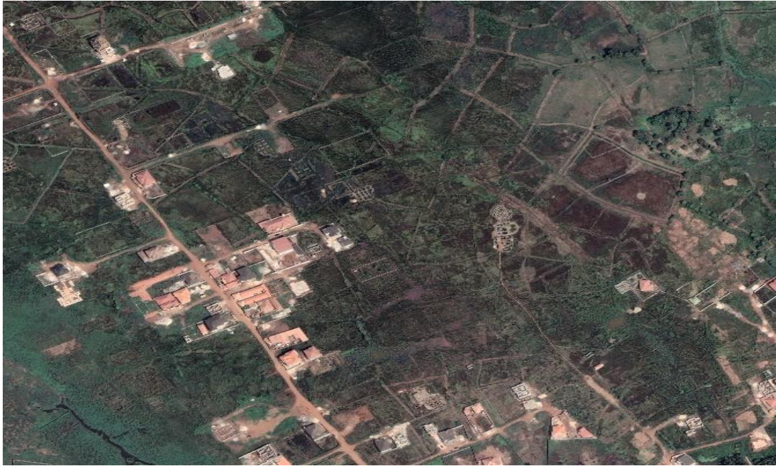
Photographie 9 : Logement en cours de construction dans la zone marécageuse de Sonfonia (Google Earth, 2022)
