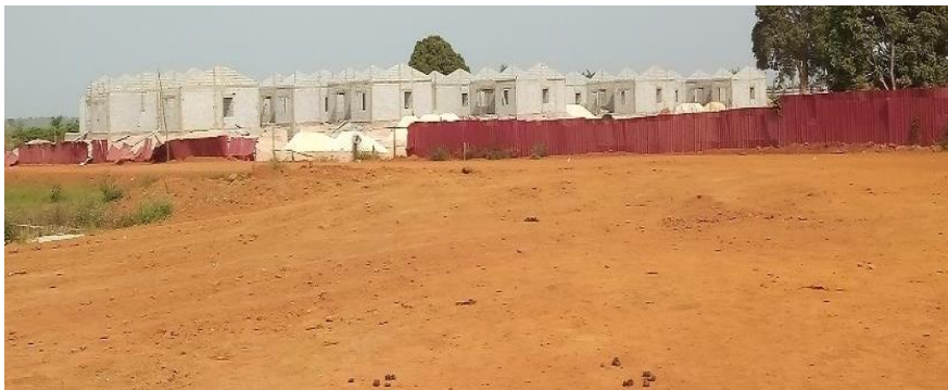
Photographie 19 : Logements en cours de construction dans la plaine agricole de Sonfonia (Bah, 2022)
