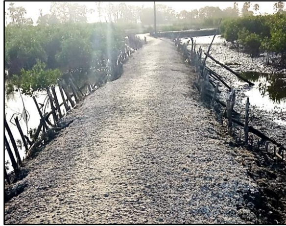
Photo 9: Digue ralliant les quartiers de Houbaak - Essaguorou à Niomoune ( Source : Sané, mars2021 )
