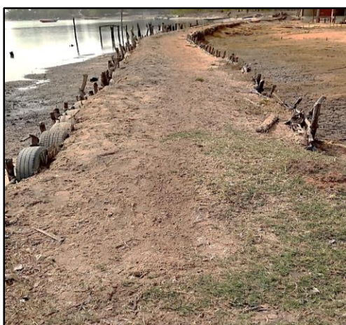
Photo 25: Digue de protection à Niomoune. (Source : Sané, Avril 2021)
