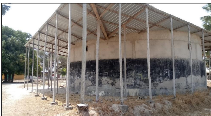
Photo 1: Système de collecte et de conservation d'eaux pluviales construit en 1994 par ENDA dans le village de Niomoune ( Source : Sané ; mars 2021 )
