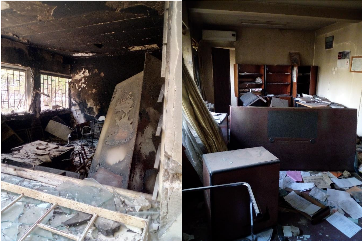
Figure 1-3 : Bureau du DRH de l'UGB (à droite), Bureau du SG de l'UGB (à gauche) [1].
