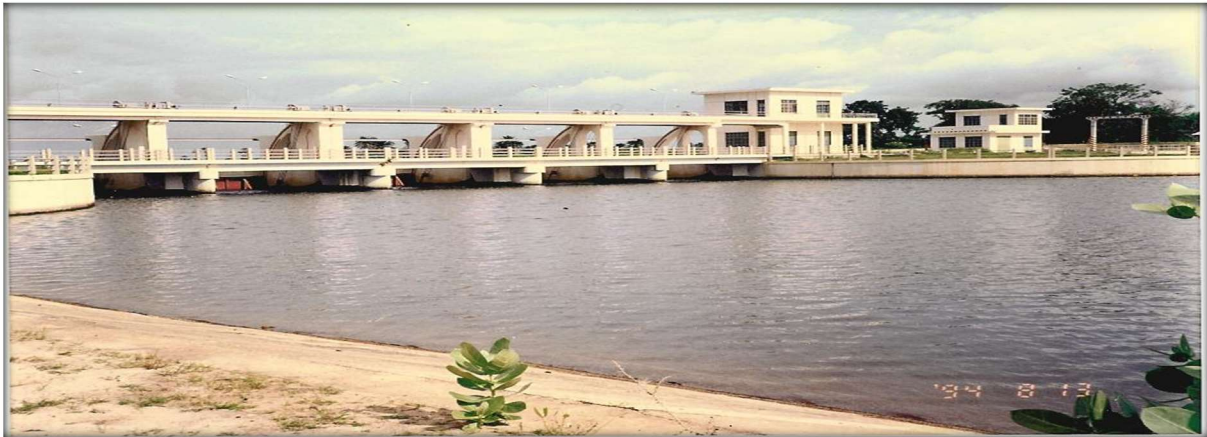
Figure 22 : le Barrage d'Affiniam
