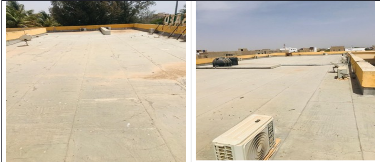
Figure 3. 6 : Vue de dessus du toit du bâtiment de la SAED à saint louis.
