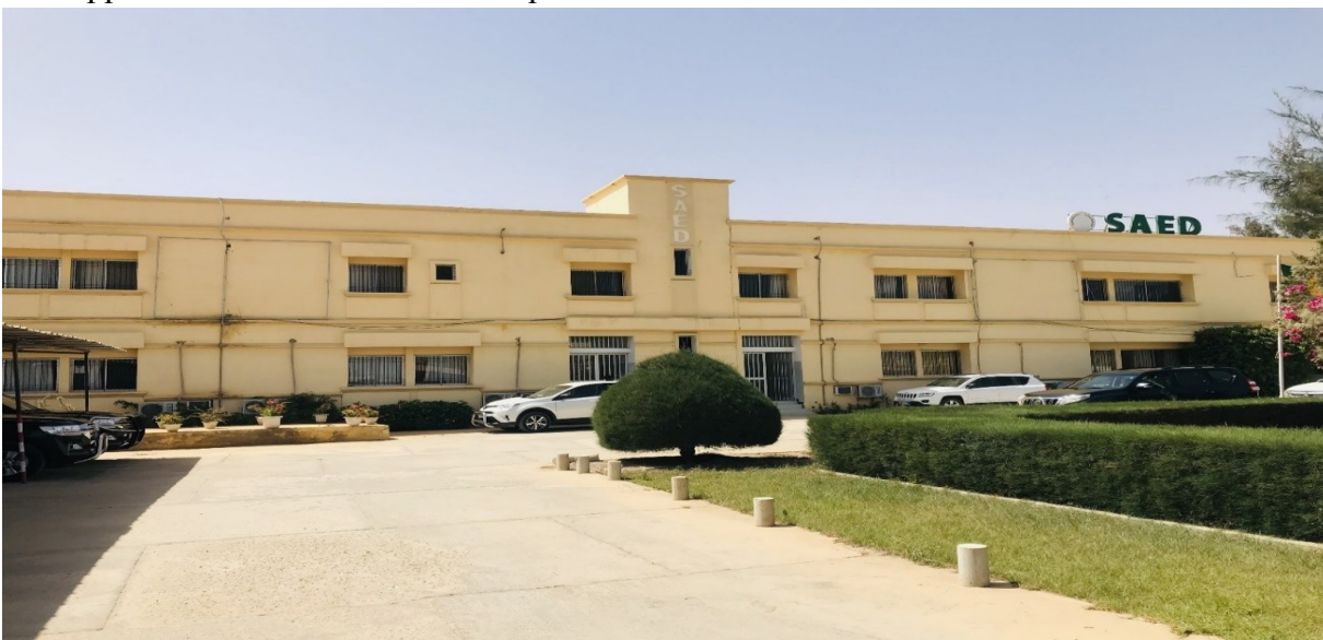
Figure 1. 1 : image de la vue de face du bâtiment de la SAED (source Cheikh DIOUF : téléphone portable)
