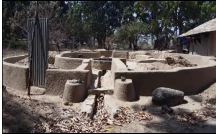
La base de construction d'une case à impluvium
