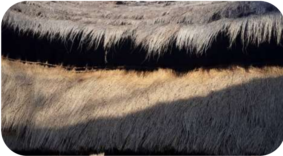
Les deux toitures à l'extérieur
