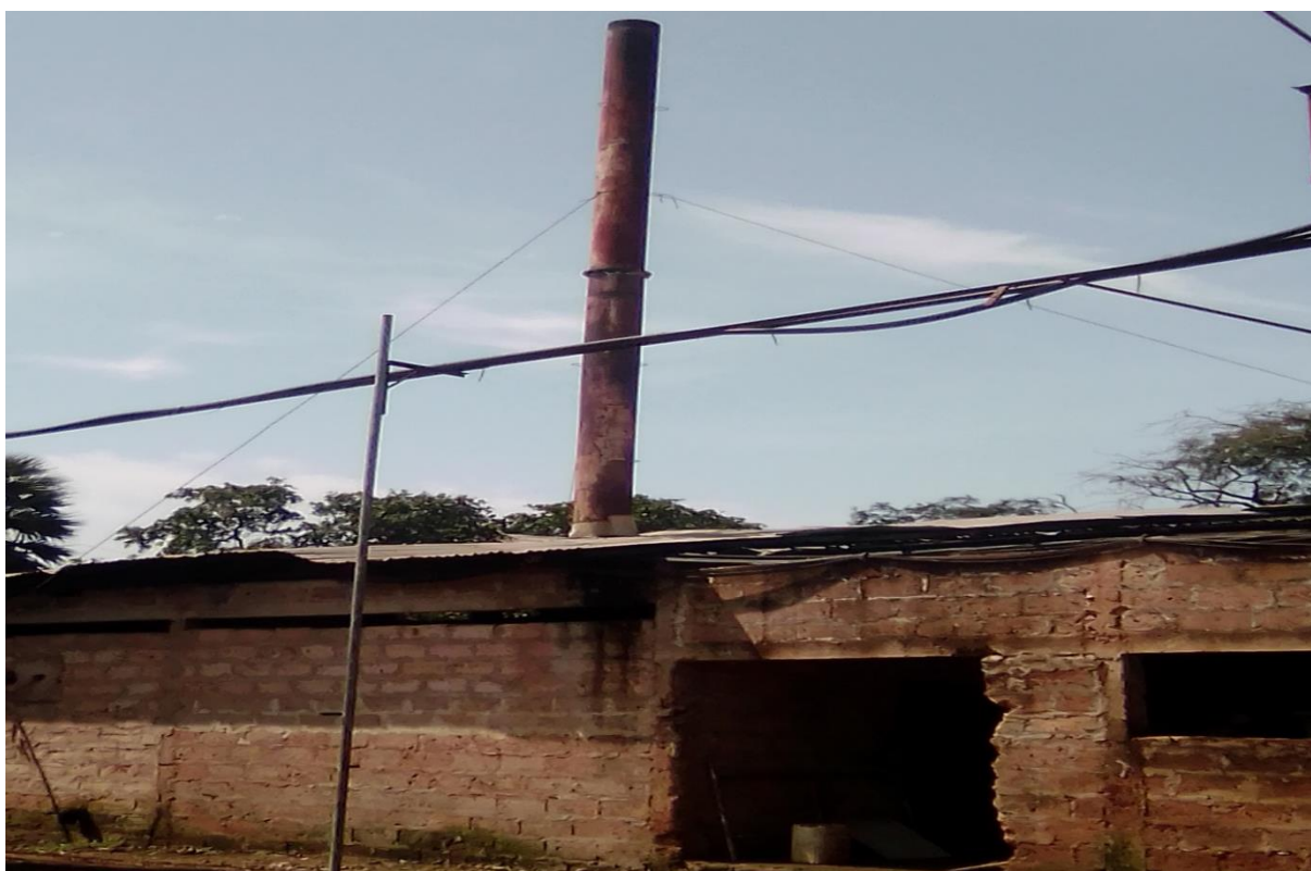
Photo 8 : le tuyau qui libère la fumée pendant la préparation des noix
