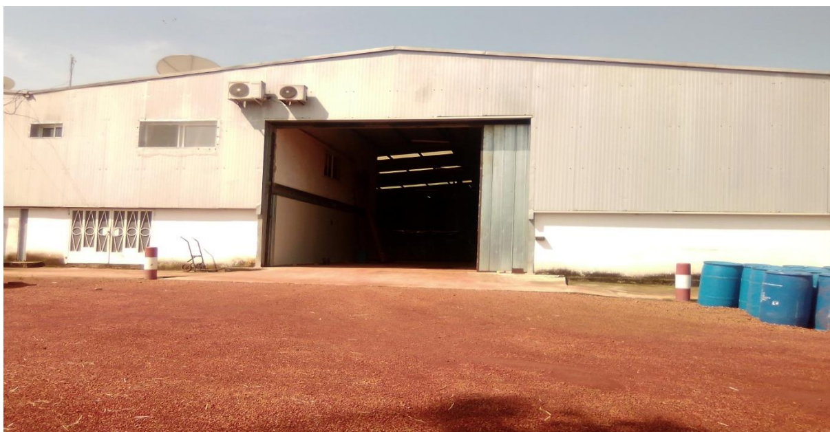
Photo 3 : Le bâtiment de l'usine
