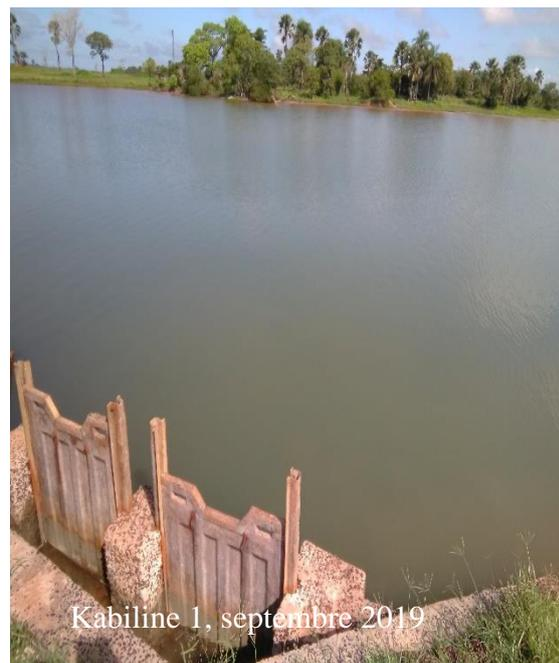
Photo 13: Parcelles inexploitées à cause de la fermeture des vannes qui engendrent un très plein d'eau dans des parcelles.
