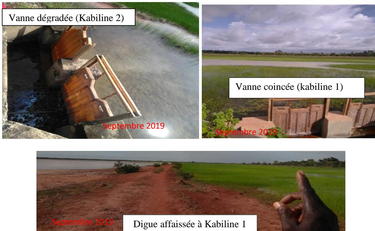
Photog 15: Les problèmes liés aux ouvrages et au remblai
