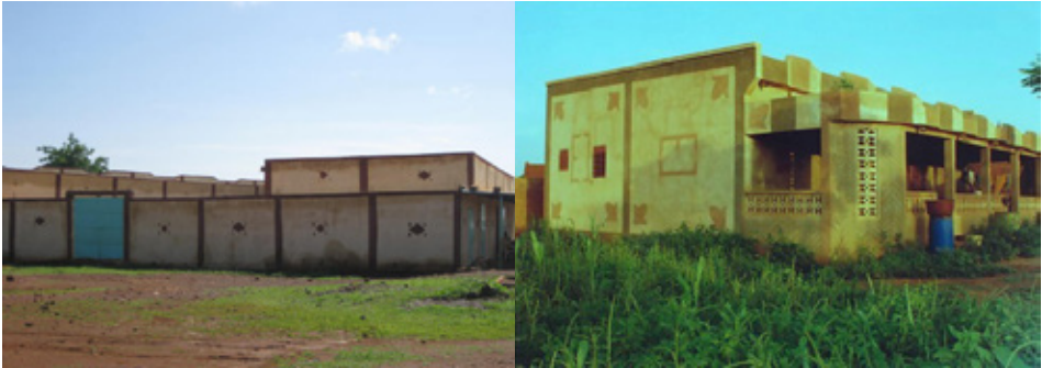
Photo N° 4. Maisons construites par les migrants à Assougé et Allakaye.
