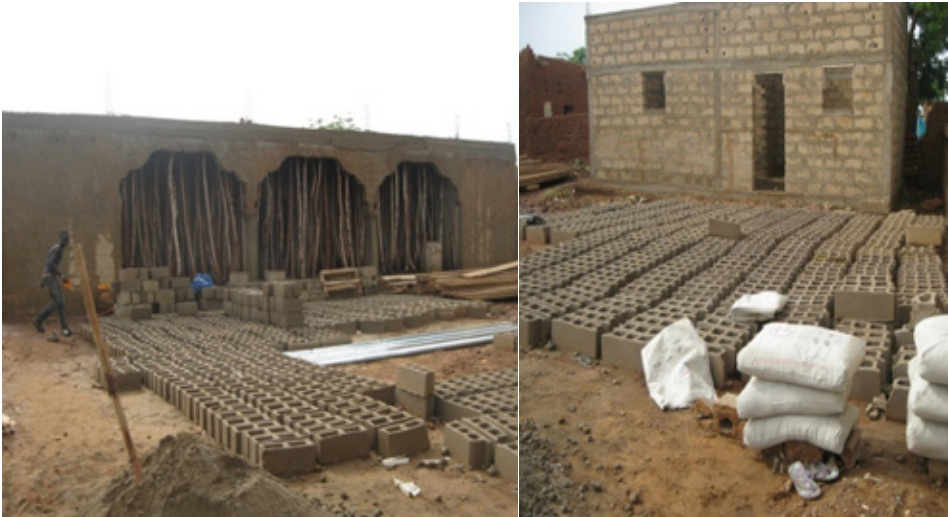
Photo N° 5. Chantier d'une mosquée et ses annexes à Allakaye Gabass.
