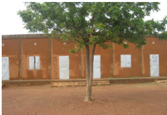
Photo N° 2. Classes en matériaux définitifs construits par les migrants d'Allakaye.
