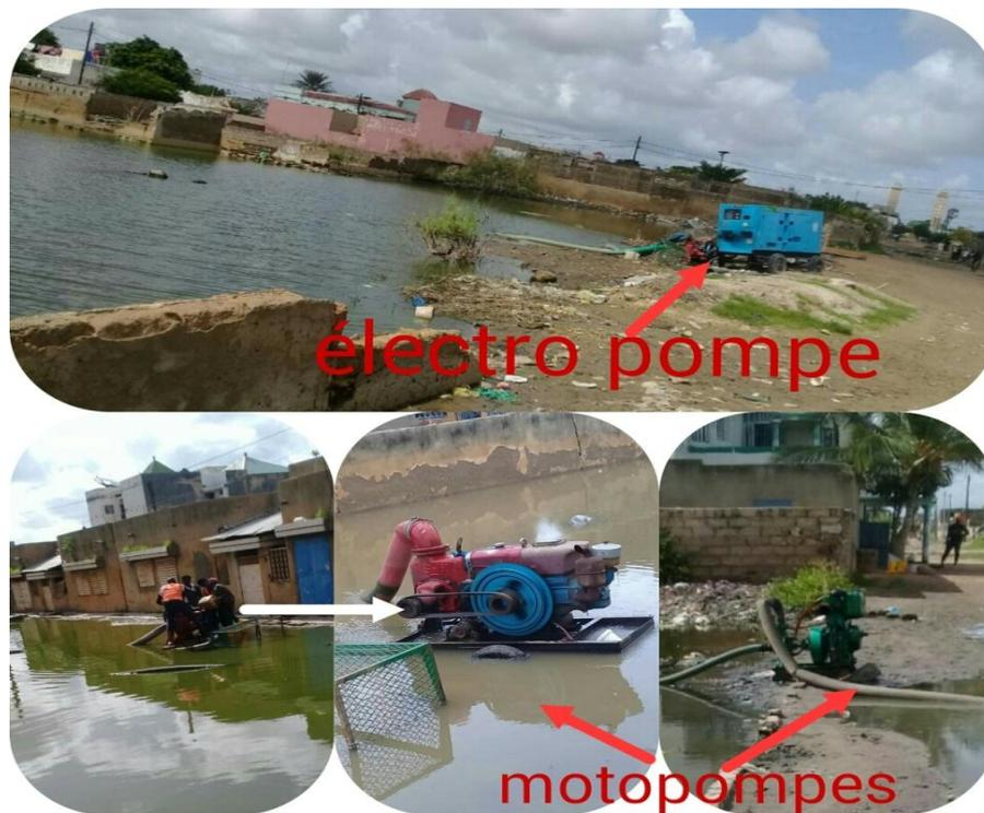
Photo 11: Installions de motopompes et d'une électro pompe à Sam (Ndour, Septembre 2020).
