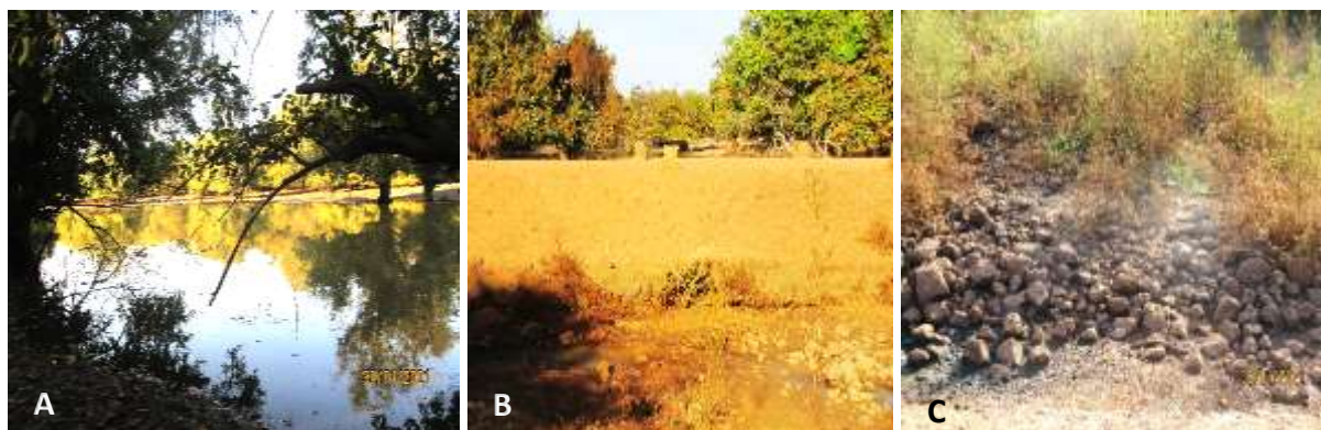
Photo 3 : Le Niaoulé en amont du pont (A), le pont de Niaoulé Tanou (B), et le Niaoulé en aval du pont (C) (Cliché SENE, février 2021)
