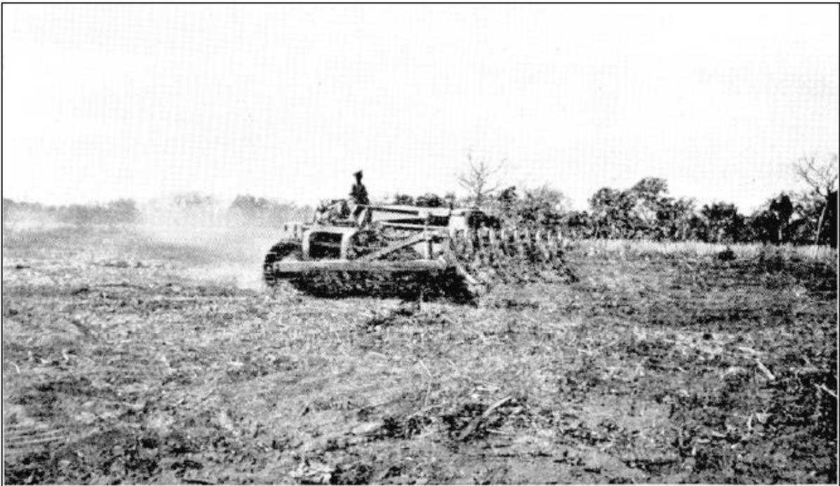
Photo 1: Caterpillar équipé d'un rootrake pour l'andainage de la végétation abattue à Séfa en 1951 (Pélicier, 1966)
