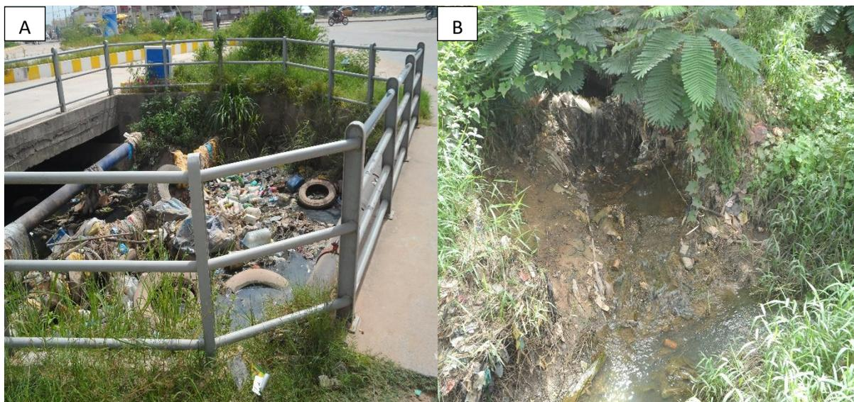
**Photo 10** : Canal obstruée par des déchets solides (A), faible débits d'eaux de ruisselllements en aval du canal à cause de l'importance de la charge solide (B). (Cliché, Sané, 2017)
