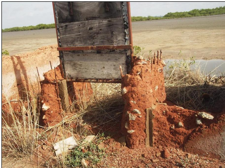
**Photo 9:** Ouvrage d'évacuateur d'eau détérioré à Adéane (SANE M. 2016)
