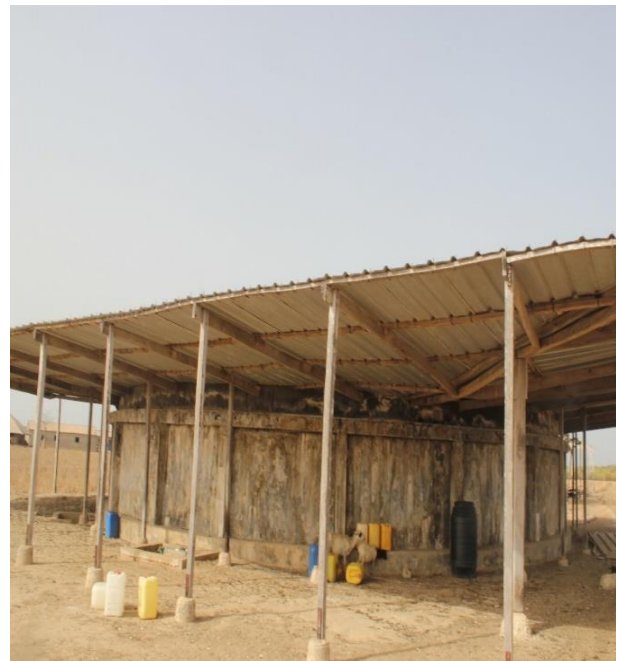
Photo 17: Nouveau bassin de stockage d'eau de pluie fonctionnel (Cliché: A. Sagna 2018)
