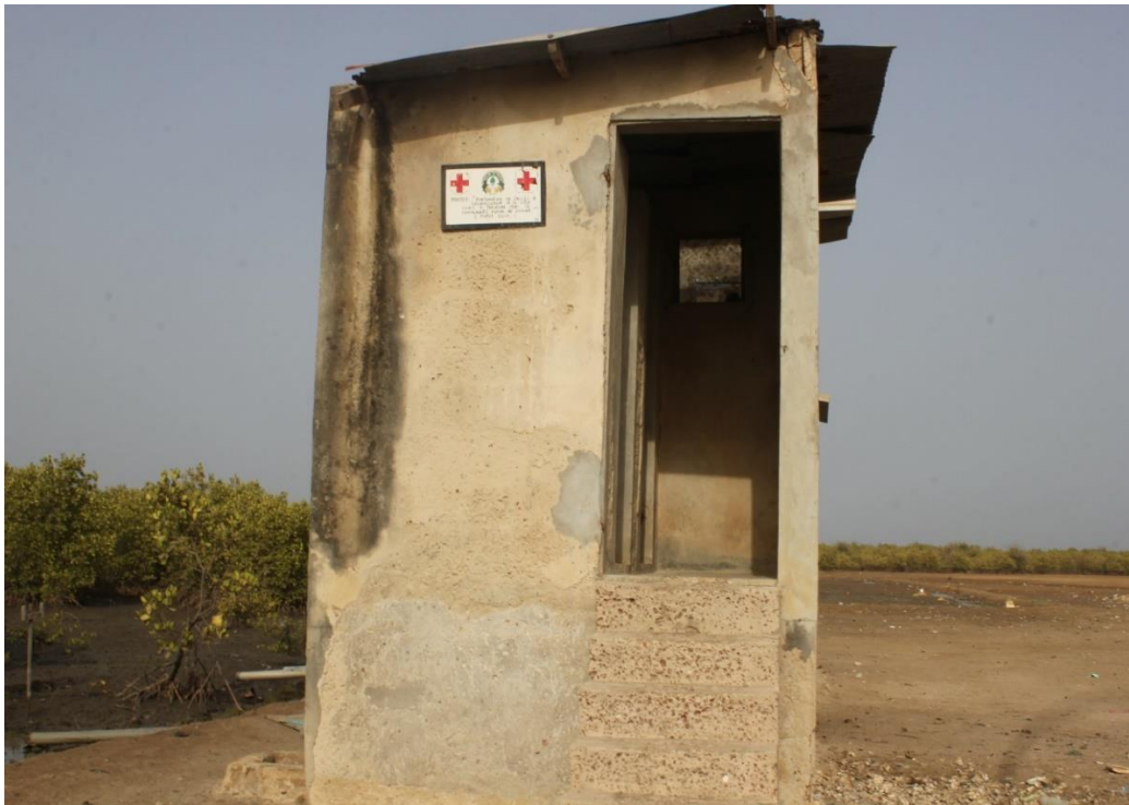
Photo 15: Latrines construites par la croix rouge à Eloubaline (Cliché: A. Sagna)
