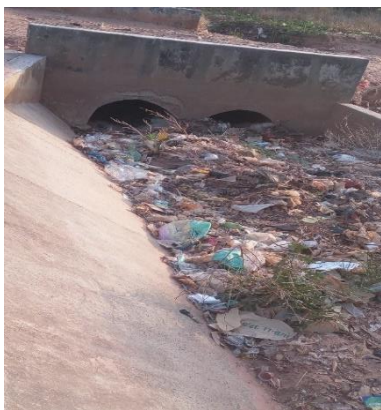
Photo 2: Canaux d'évacuation d'eaux à Kandialang Ouest (Source : Auteur, 12/04/2016)
