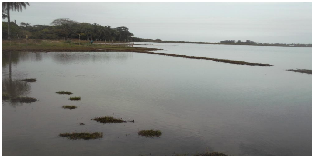
Photo 28: Elargissement du chenal et destruction de la digue de protection des rizières (BOCOUM, Juin 2017)
