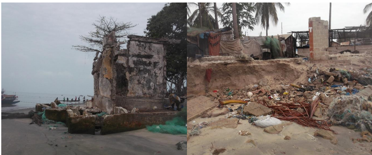
Photo 14: Bâtiments des pêcheurs abandonnés à Diogué (BOCOUM, Juin 2017)
