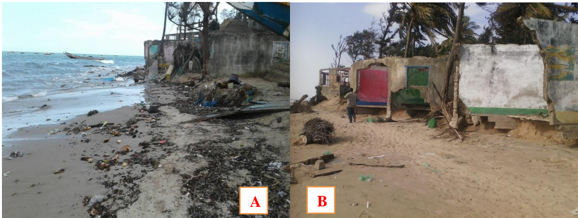
Photo 12: Destruction du campement la nature par l'érosion côtière
