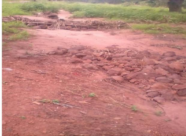
**Photo 19** : Diguettes en cadre détruite par les eaux de ruissellement à Bodeyel Talata (Saïdou Baldé)
