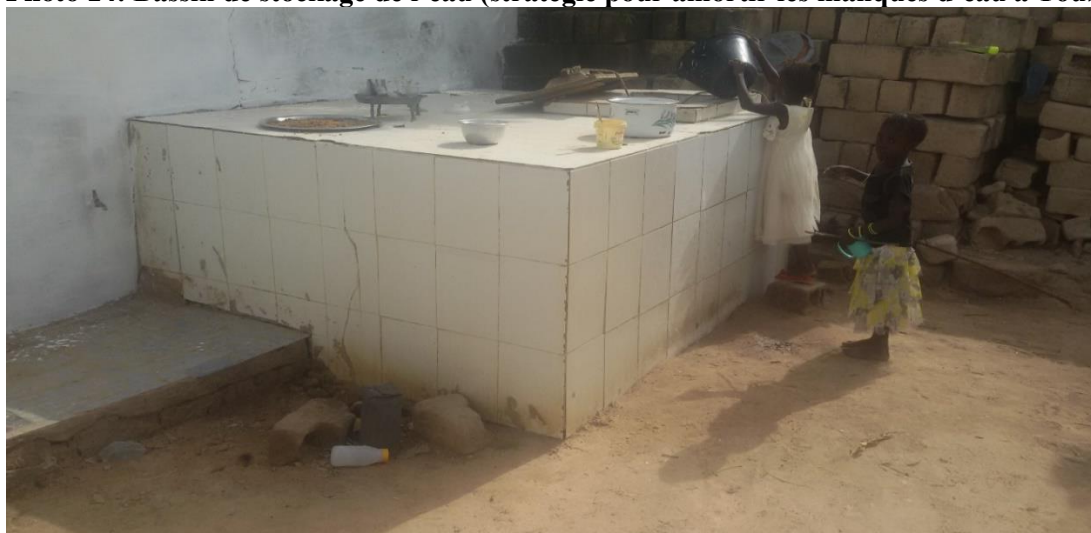
Photo 14: Bassin de stockage de l'eau (stratégie pour amortir les manques d'eau à Touba)
