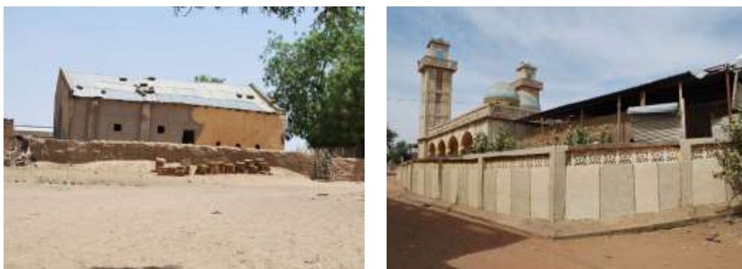
Figure 15: Ancienne mosquée de Séno Palel
