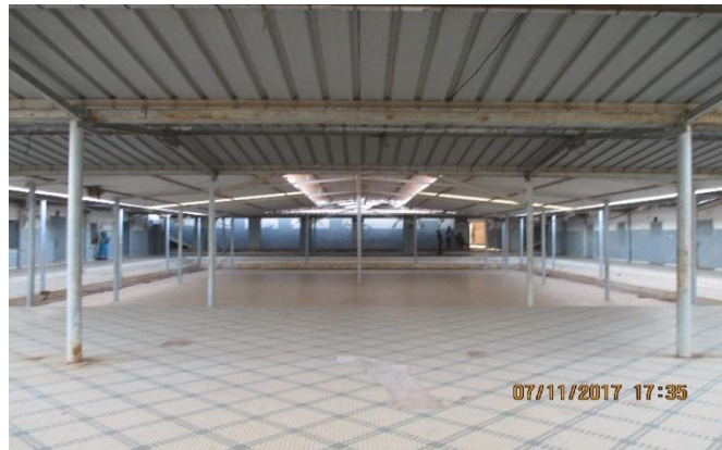
Photo 2 : Le Fort Piné Laprade, vue de l'intérieur
