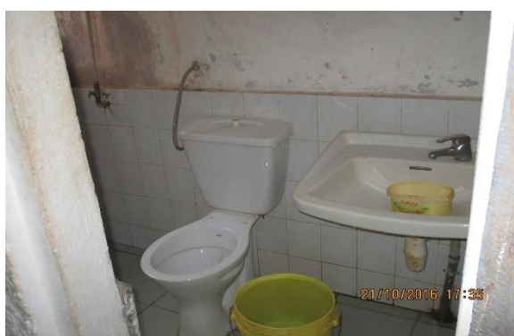
Vue des toilettes
