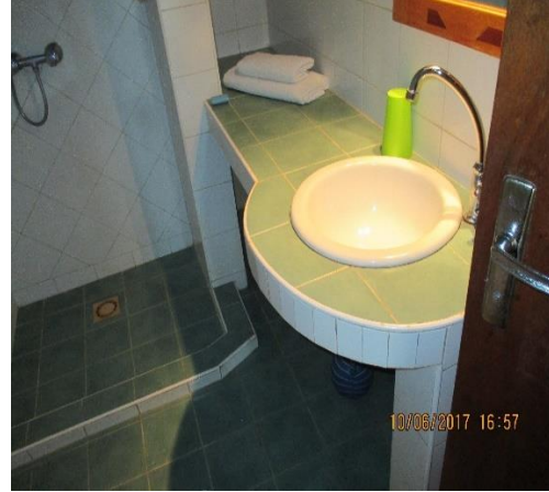
vue de la toilette de la suite
