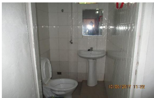
Vue des toilettes
