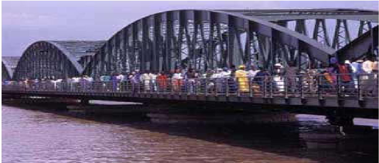
Photo 8: le pont FAIDHERBE
