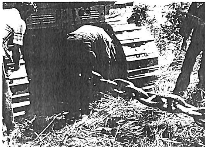
Principe de défrichage à la chaîne, adopté par Razel pour le chantier de Savé Cette méthode qui nécessite l'utilisation de deux tracteurs lourds, est la plus économique et la plus rapide
