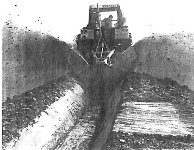
Rigoleuse en action
