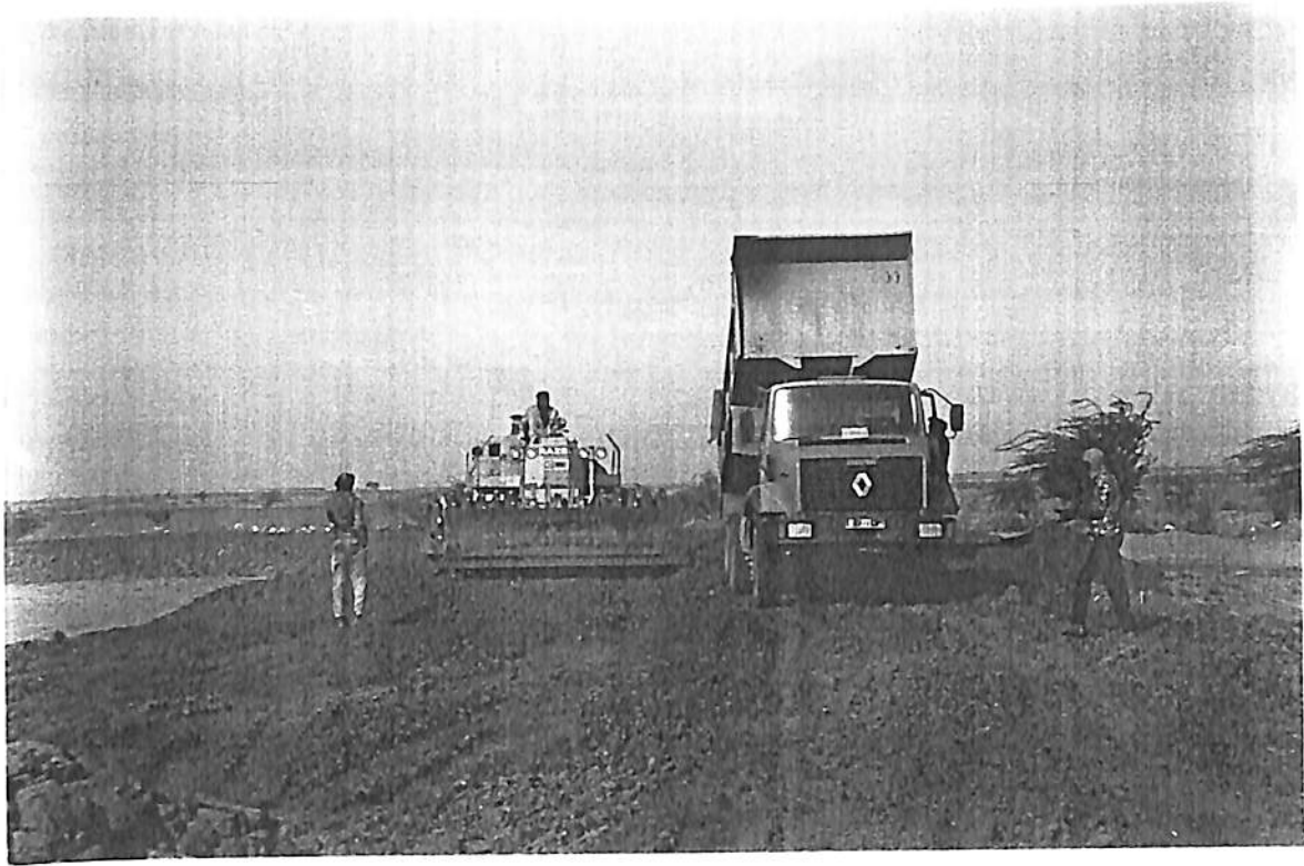
Décharge et compactage (échelon camions)
