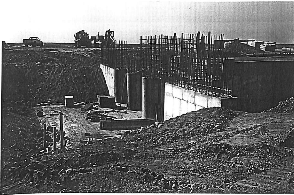
Ouvrage hydraulique (OMVS)
