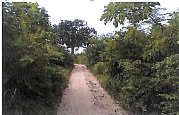
Piste sableuse sur emprise réduite
