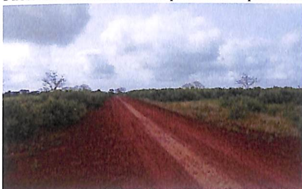
Piste latéritique réhabilitée
