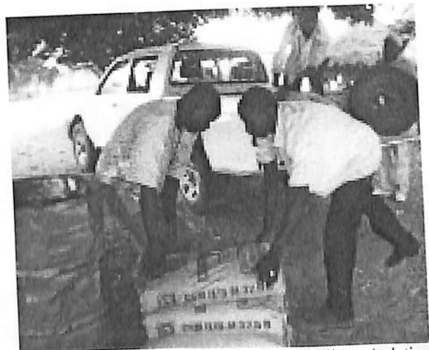
Dépôt du ciment (cuve) et du fût métallique (solution d'urée) chez M. Mamoudou Sabaly à Daïbatou Kossy (Dioulacolon). Campagne 2009-2010
