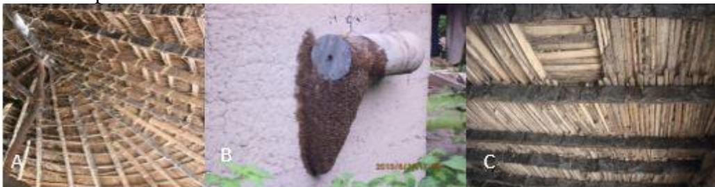
Figure 6: Usages du stipe du palmier A: Charpente, B: Ruche traditionnelle C : Plafond
