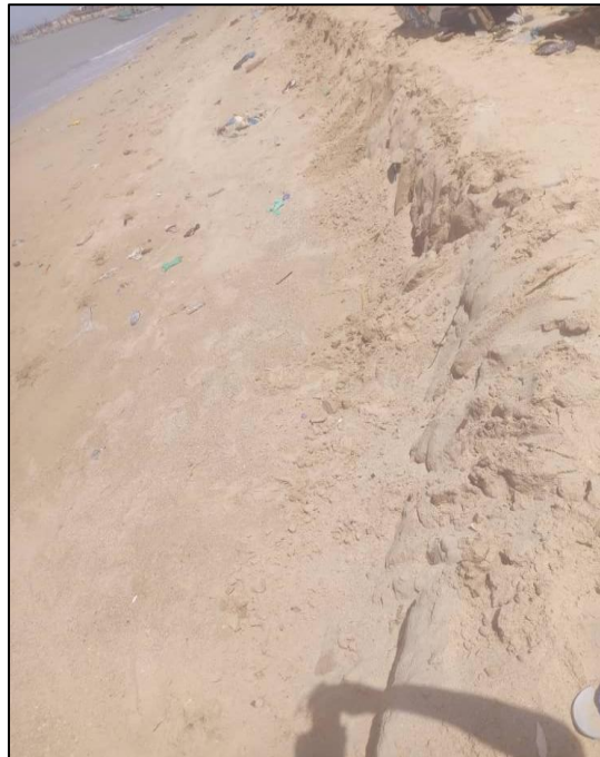
Photo 4: Érosion à la plage à Teffess, Mbour (Yade, Avril 2025)
