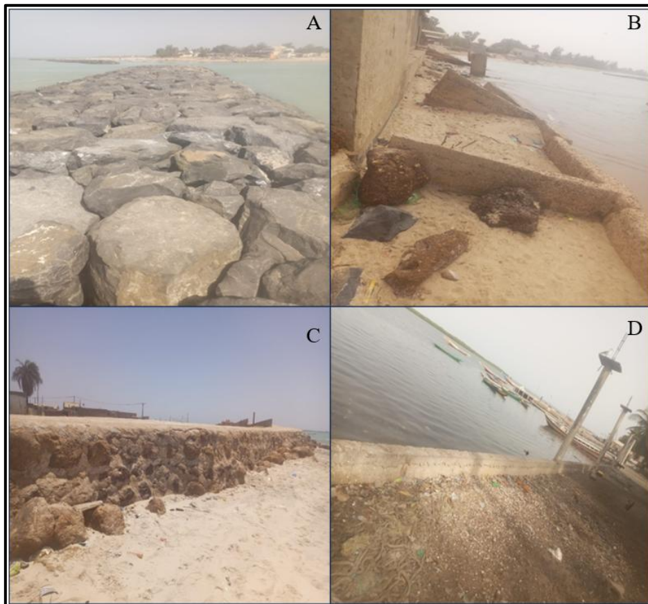
Planche photographique 1 : Ouvrages de protection sur la Petite-Côte sénégalaise (A : Saly Portudal ; B : Pointe Sarène ; C : Djiffer ; D : Bétenty)
