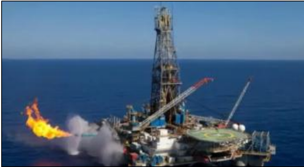
Photo 3: Plateforme offshore de Sangomar (ADS services, juin 2024)
