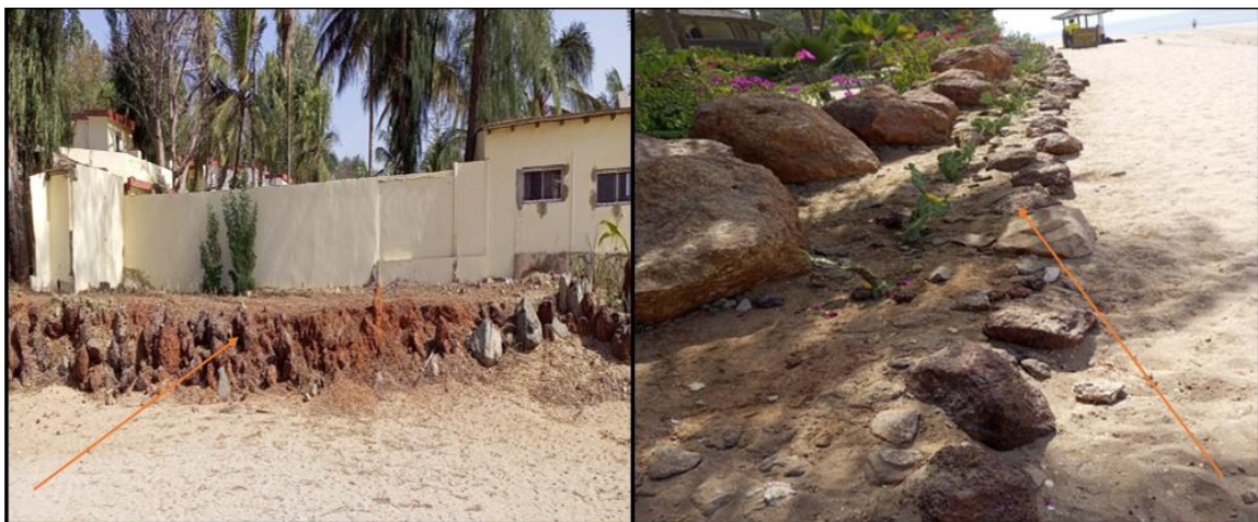
Planche photographique 17: Enrochement aux abords des hôtels à la station balnéaire de Saly Portudal (Yade, Février 2022)
