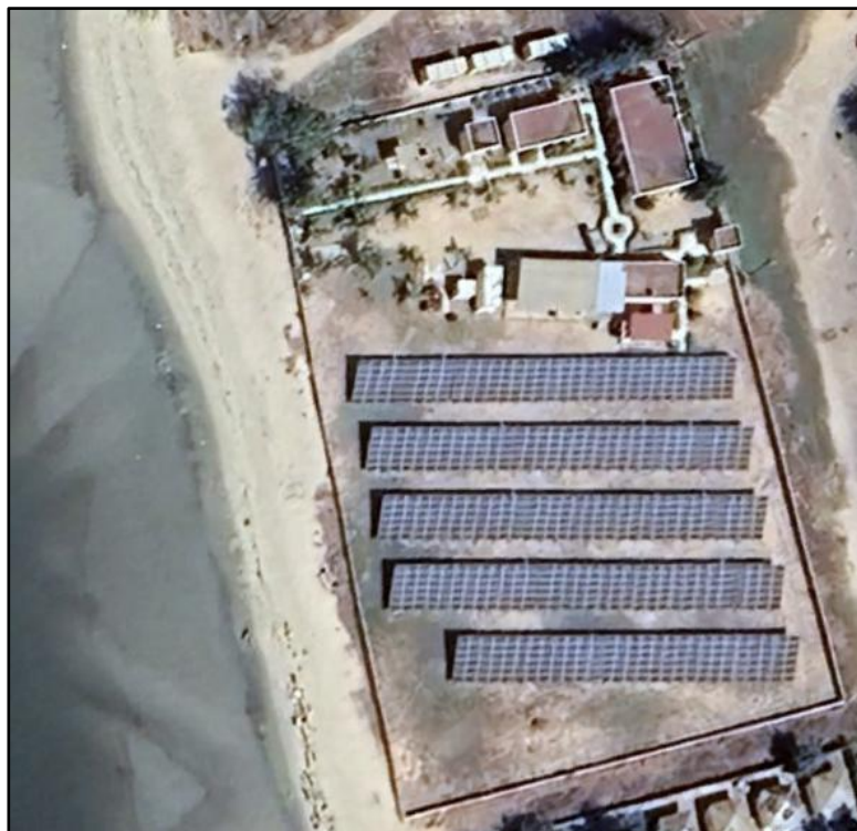
Photo 2: Une centrale solaire construite sur la plage de Bétenty (Image Google earth, 2025)
