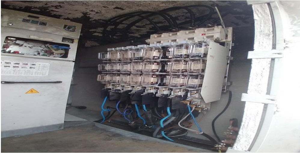
Figure IV.3 : Tableau urbain réduit à huit départs porte-fusible
