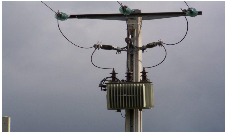
Figure II.10 : Poste sur poteau de type H61 [12]
