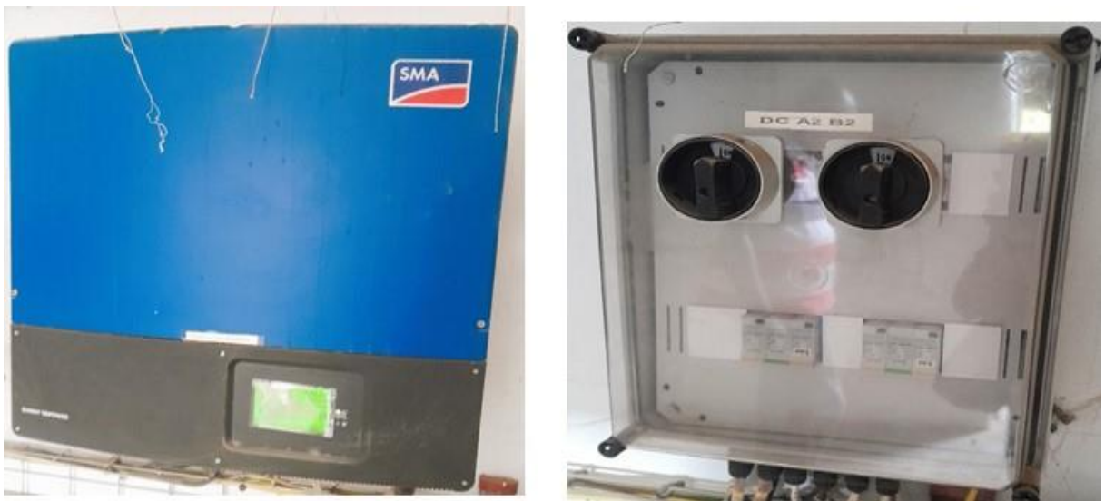
Figure 11 : Photo de l'Onduleur SMA triphasé (a) système de protection DC (b)
