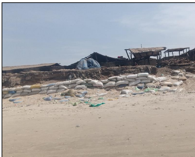
Photographie 25: Des sacs de sables pour lutter contre l'érosion côtière au QPK (février 2023)
