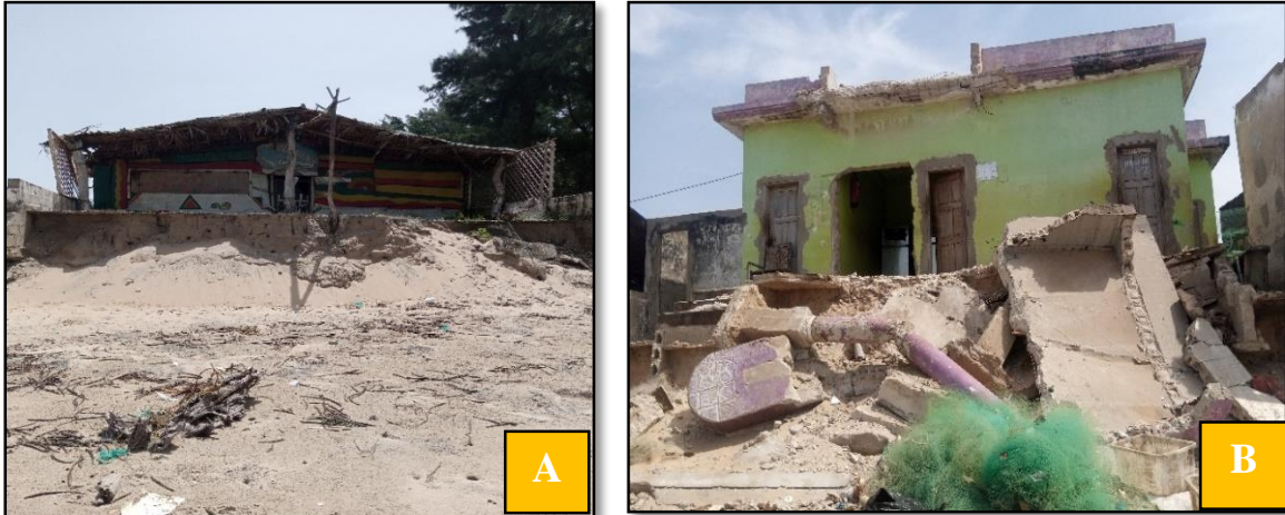
Photographie 20: (A) Destruction d'une infrastructure de tourisme au niveau du débarcadère d'Abéné ; (B) Destructions d'une station-service par l'avancé des eaux au QPK (février 2023)
