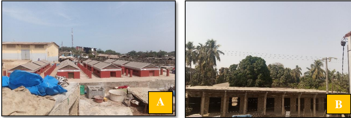
Photographie 23: (A) Séchage moderne au QPK; (B) Boutique moderne en construction au marché de Kafountine (février 2023)
