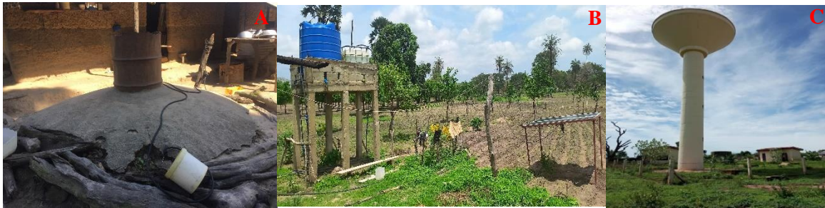
Photo 7 : (A) Puits à margelle traditionnelle destinée aux usages domestiques à Agnak-Grand (novembre, 2020) ; (B) mini-forage solaire à Baroufaye-Bainouck (juillet, 2022) et (C) Forage communautaire à Camaracounda (juin, 2023).
