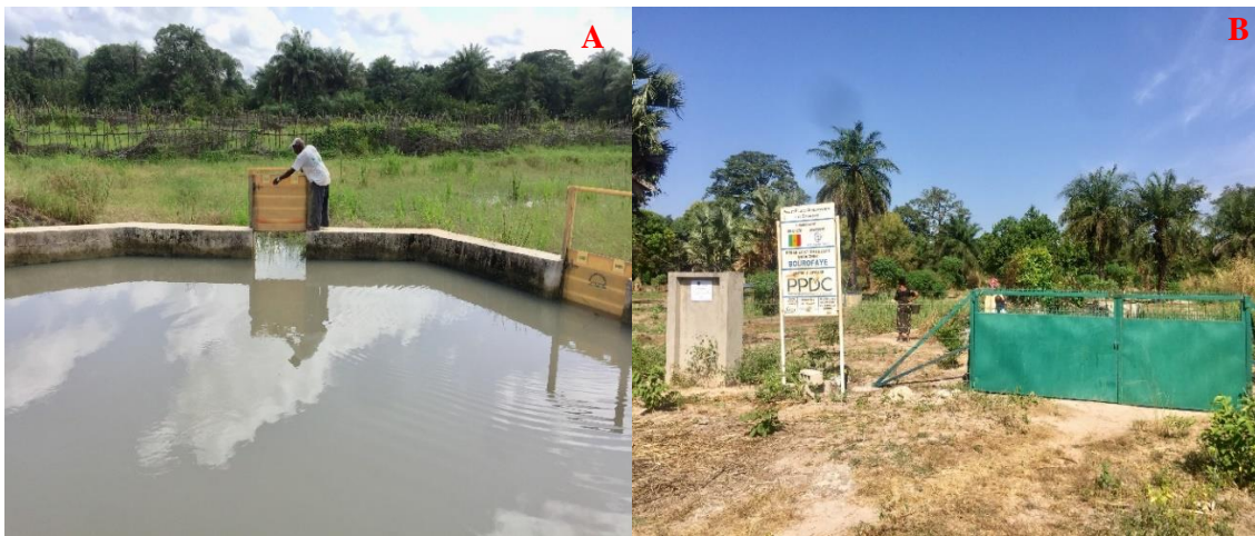
Photo 1 : Ouvrage de rétention des eaux pluviales à Mpack (A) ; une vue de la ferme agricole aménagée par le PPDC à Bourofaye-Baïnouck (B)
