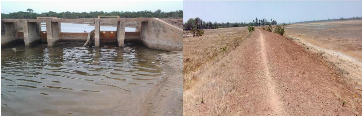
Planche 15: quelques méthodes de lutte mécanique dans le bassin versant de Diouloulou : endiguement et micro-barrage (Cliché Sané, 2020)
