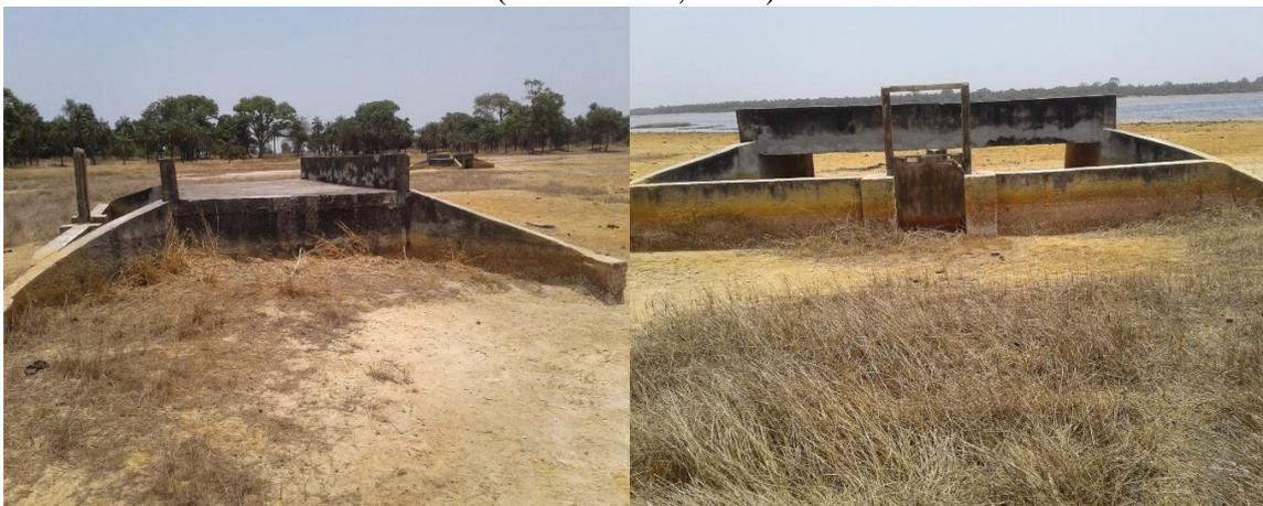
Planche 22: barrage abandonné par manque de renouvellement de la Digue à Karongue (Cliché Sané, 2020)
