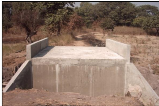
Photographie 9 : Ouvrage de franchissement à Bolibana (BARRY, Juillet, 2022)
