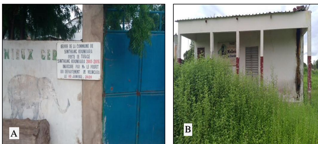
Photographie 10: Poste de triage (A) et bâtiment (B) à Sinthiang Koundara (BARRY, 2022)
