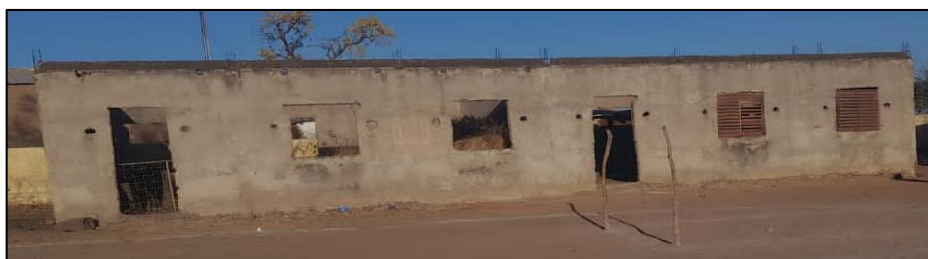
Photographie 11: Salle de classe en construction à Sinthiang Koundara (BARRY, 2022)
