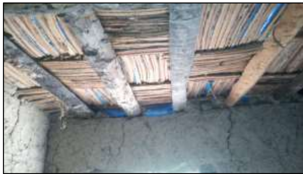
Photographie 7: Plafonds avec bois de mangrove d'une maison construite en 2005 à Senghalène (Diatta, octobre 2020)
