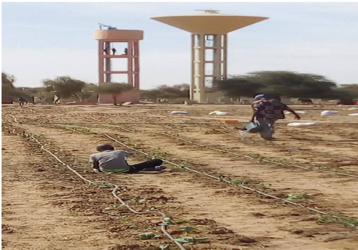
Forage multi-villages et réservoir de Thiéhel Sébé
