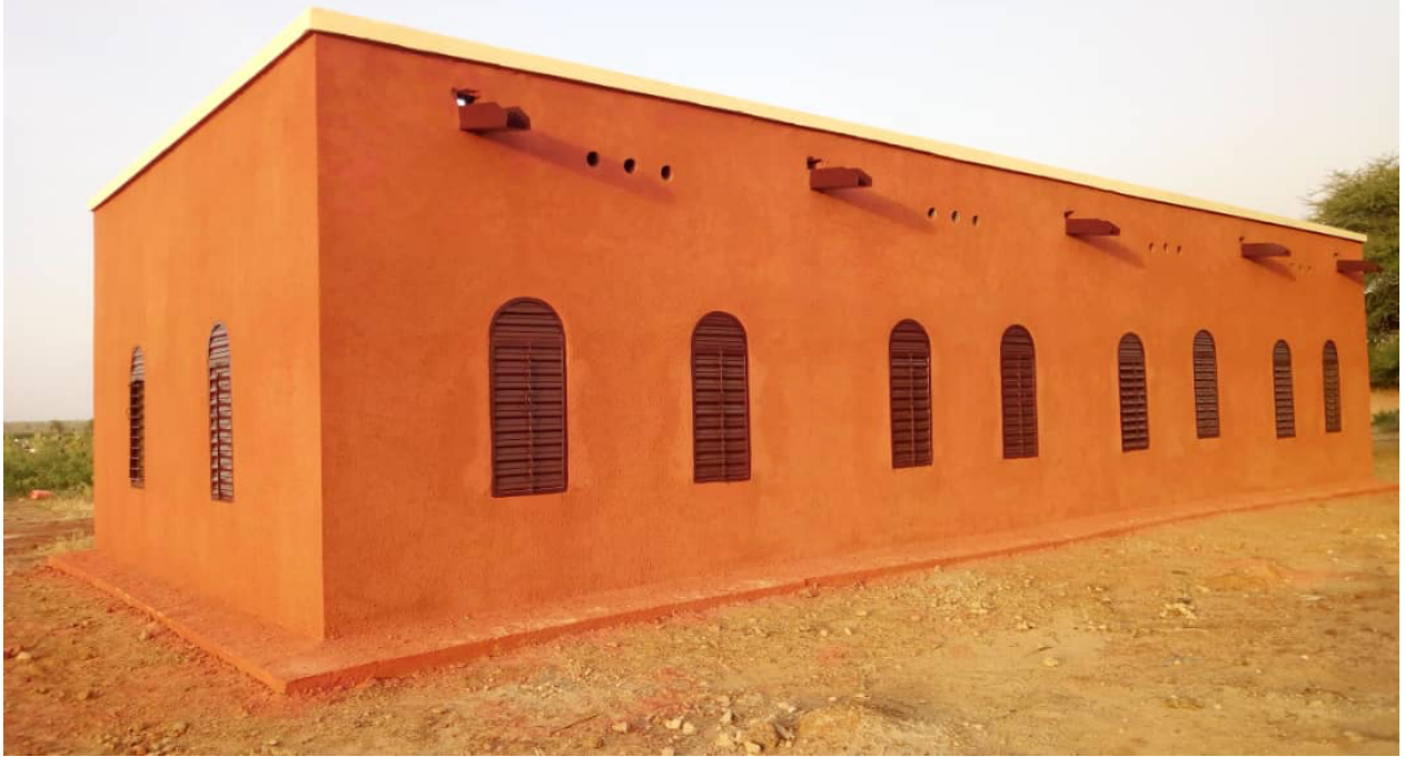
Magasins de stockage en voute nubienne des deux sites
