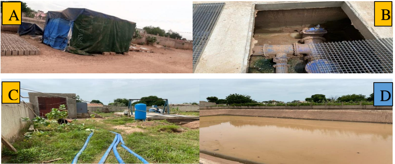
Photo 7 : Dispositif de pompage des eaux mis en place à Diamaguene centre (école-5) (A, B et C) et bassin de rétention situé à l'école-5 du quartier Diamaguene centre (D)
