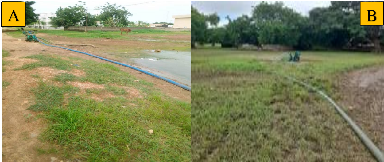
Photo 10 : Motos pompes mises en place pour le pompage des eaux pluviales à Diamaguene-centre (A) et Kaffrine 2 sud (B).
