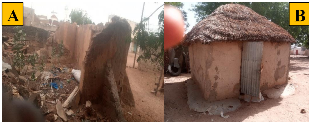
Photo 3 : Case en banco effondrée à Diamaguene-centre (A) et case construite en banco à Kaffrine 2 sud(B).
