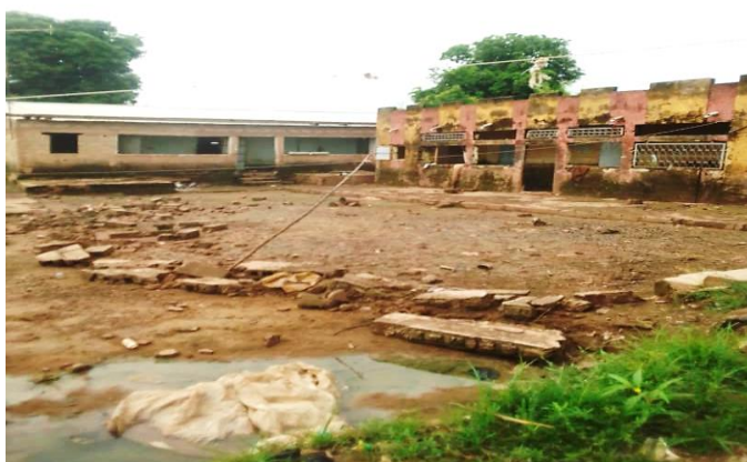
Photo 2 : Des maisons abandonnées à Diamaguene-centre à cause des inondations
