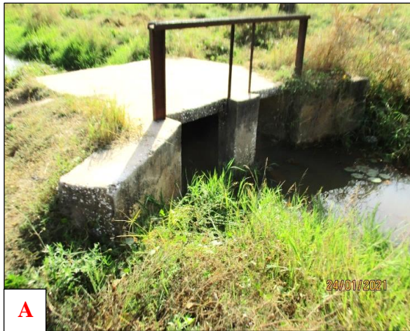
Photo 20 : Barrage anti-sel à Mandina (A) et une digue anti-sel à Djibélor (B) (Janvier 2022)
