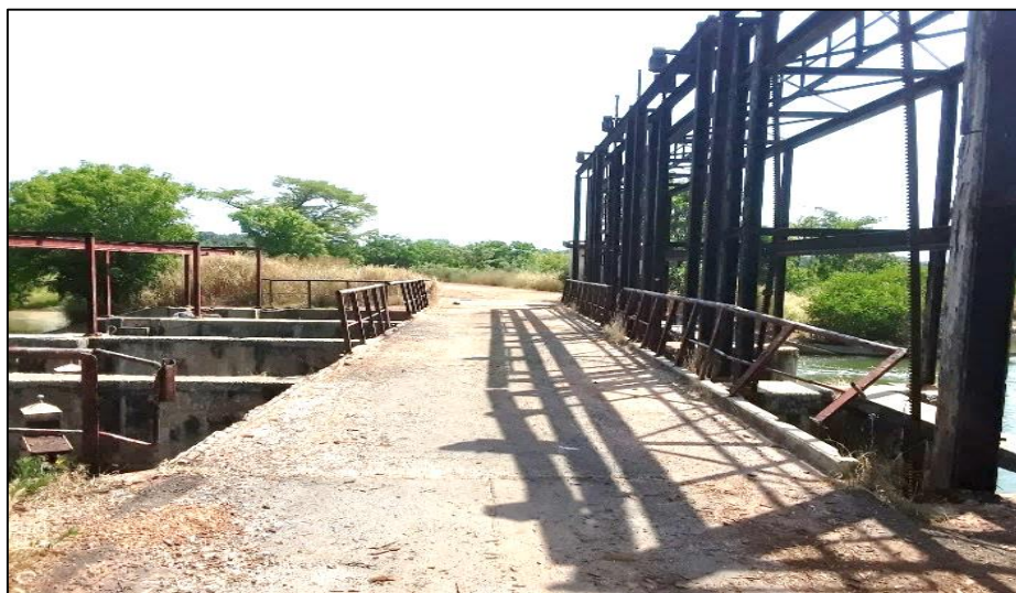
Photo 16 : Barrage anti-sel de Guidel (Janvier 2022)
