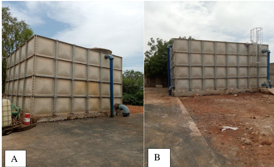
Photo 13: (A ; B) Images illustrant les Réservoirs d'eau de l'usine de dessalement ; (Source : Enquête E.Gomis ,Mai 2022 )
