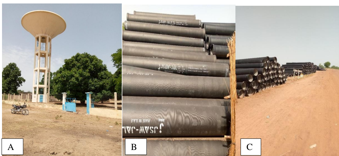
Planche de Photo 15: Images illustrant le Forage de Ndiayène Keur Moussa Ndiaye (A) et les installations des tuyaux d'eaux destinés à approvisionner Foundiougne en eau Potable (B ; C) (Source : Enquête, E.Gomis, Mai 2022 )
