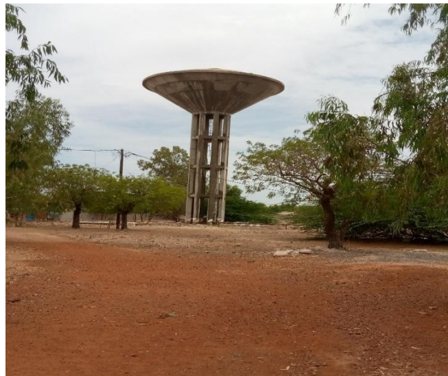
Photo 7: Forage de la commune de Foundiougne implanté dans le quartier de Thiamène
